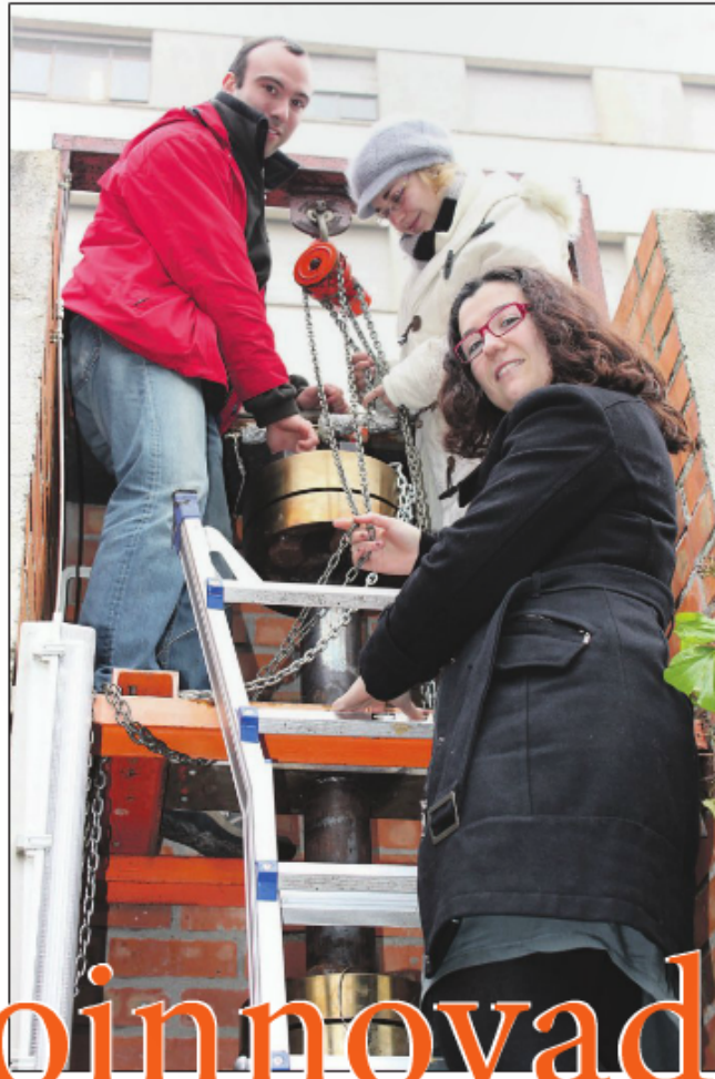
Pablo Cabeza, Lola Bermejo y Cristina Jiménez revisan la instalación donde se encuentra el reactor.
